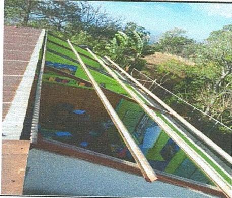
Foto 1: Avance de la reparación de Cubierta de lámina
